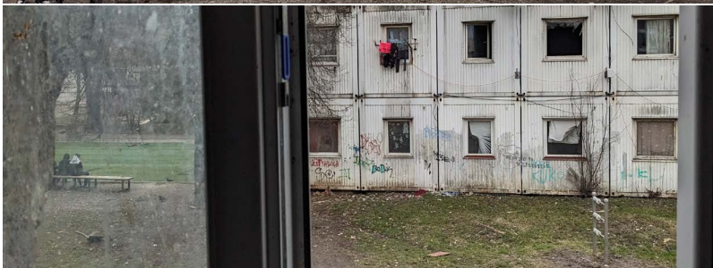
Unimobunky prenajímané ako mestské nájomné bývanie v segregovanej lokalite s mestskými nájomnými bytmi v Žiline
