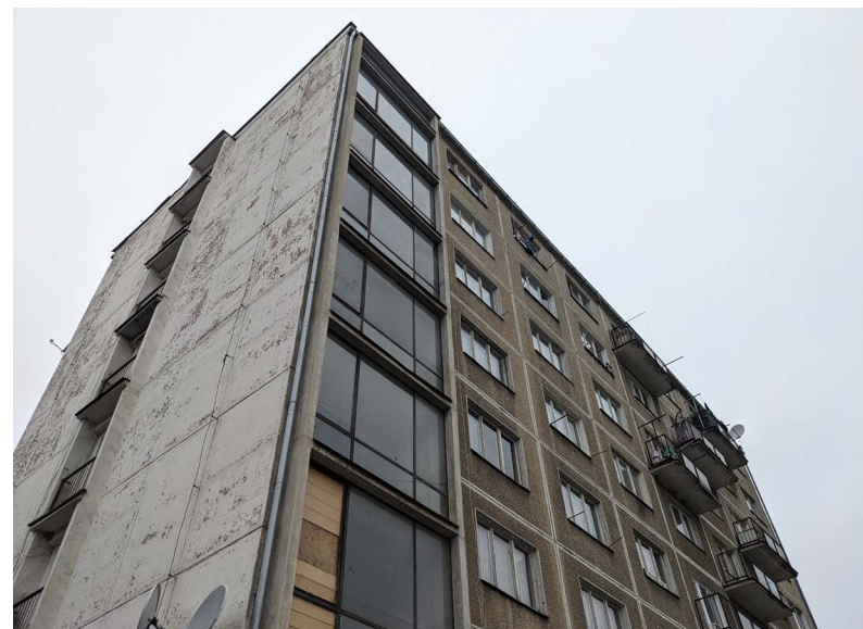
Segregovaná lokalita s mestskými nájomnými bytmi v Banskej Bystrici
